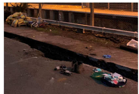
View of trench edge
